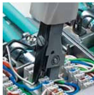
Vtlačení a ustřížení kabelu v jedné pracovní operaci
